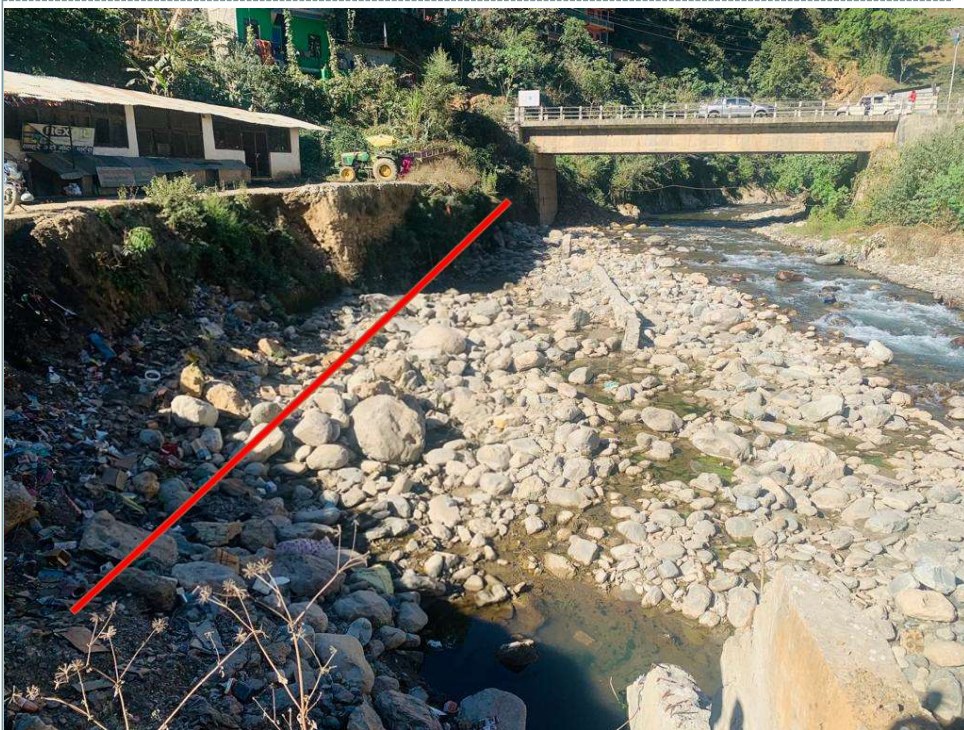
सुलिचौर बसपार्क तटबन्ध निर्माण सुनिलस्मृति-२ बजेट २० लाख
