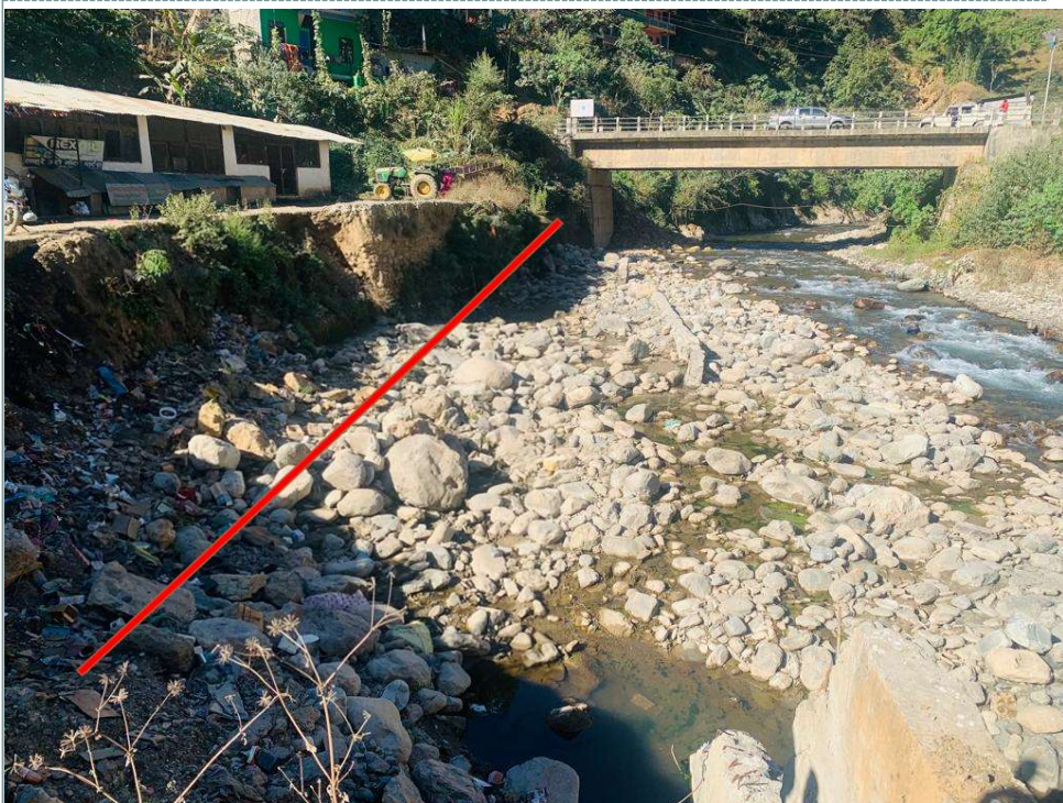
सुलिचौर बसपार्क तटबन्ध निर्माण सुनिलस्मृति-२ बजेट २० लाख
